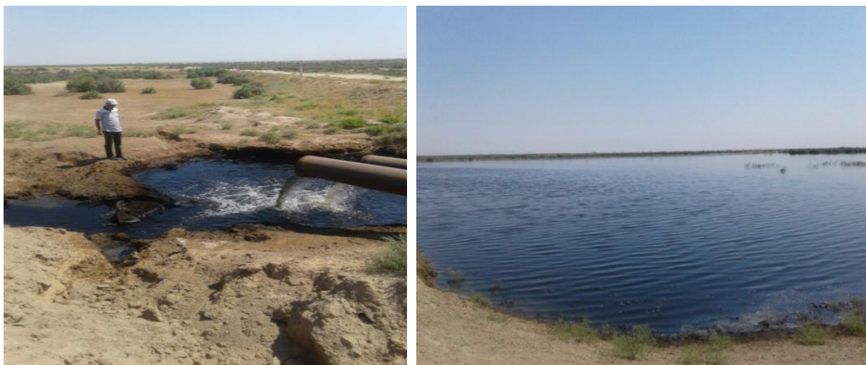
Рис. 1. Естественные поля фильтрации Муберек ГПЗ: а) вид спуска производственных стоков на естественные поля фильтрации; б) общий вид естественного поля фильтрации
