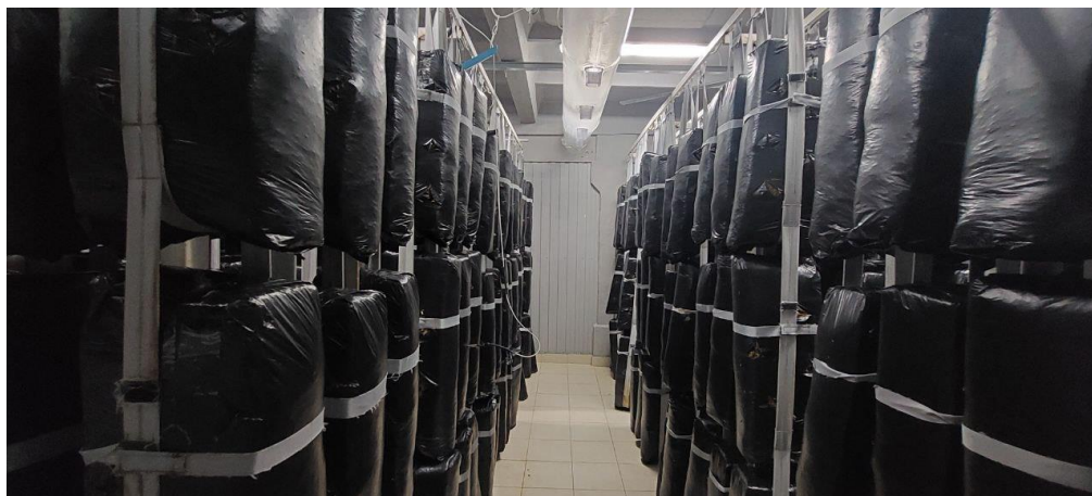
Рис. 5. Подвесная система размещения блоков в камере инкубации
